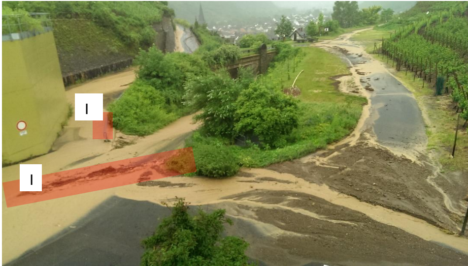
Abb. 17: Beispielanlagen in Dernau bei Starkregen (Bildquelle: M. Großgarten)
