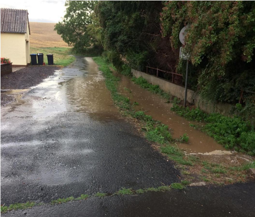
Abb. 4: Überlasteter Einlaufbereich in Verrohrung in Kerben-Minkelfeld bei Regenereignis 2019 (bereitgestellt durch Bürger:innen der VG Maifeld)
